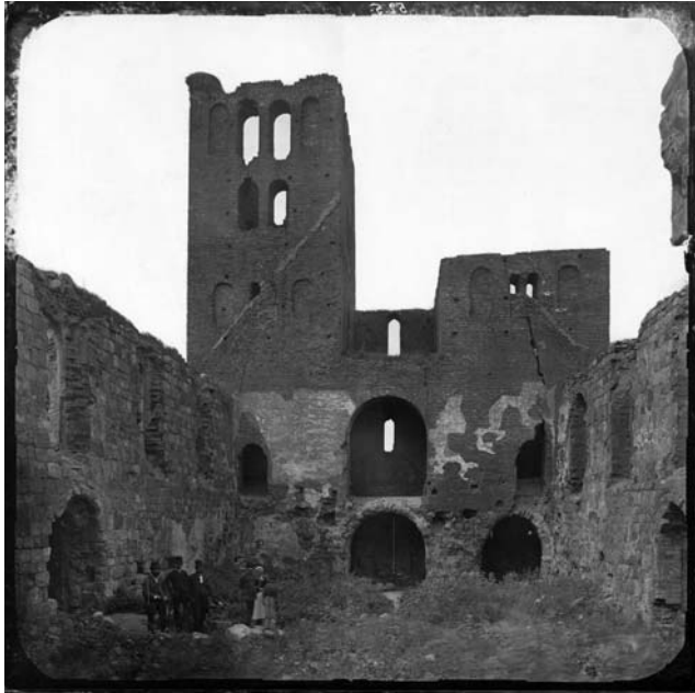
Fot. nr 523. Kościół pw. NMP w Inowrocławiu widok na emporę i wieżę wykonany od wewnątrz budowli.
