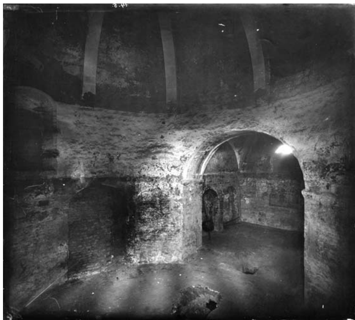
Fot. nr 534. Wnętrze rotundy pw. Św. Krzyża w Strzelnie.
