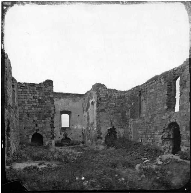
Fot. nr. 524. Kościół pw. NMP w Inowrocławiu widok na prezbiterium wykonany od wewnątrz budowli.
