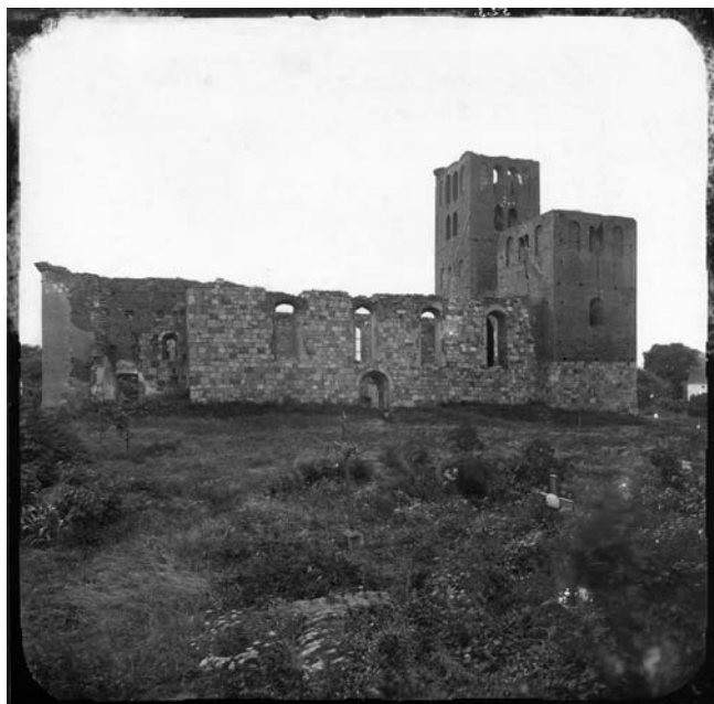
Fot. nr 521. Kościół pw. NMP w Inowrocławiu. Widok od strony północnej.
