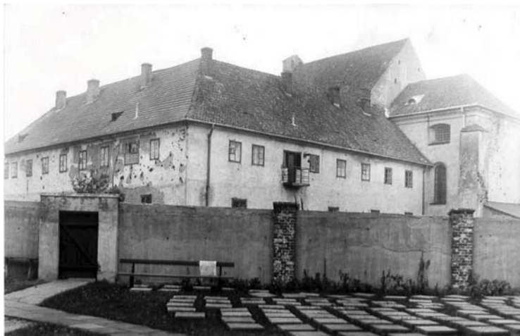
Fot. 2. Klasztor łowickich bernardynek z uszkodzeniami po działaniach wojennych/ Photo 2. The damaged Bernardine Sisters Convent in Łowicz after the war.
