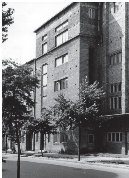
Fot 4. Widok gmachu Biblioteki KUL od strony ul. Chopina, przed przebudową w latach 1960-1971. Zbiory autora.
