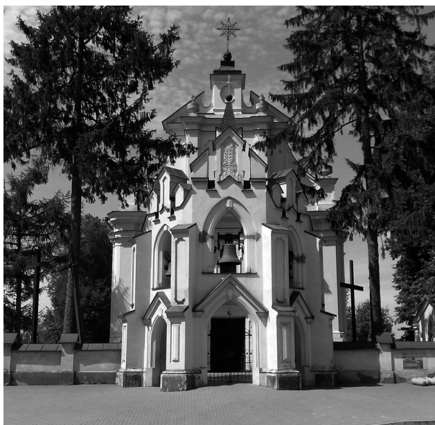
Fot. 12. Dzwonnica w Abramowicach. Fot. H. Mącik.
