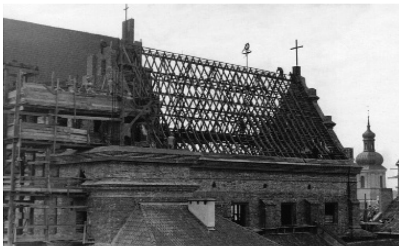
Il. 13. Odbudowa kościoła Najświętszej Marii Panny Łaskawej (1950-1952) Zbiory Archiwum PWM, Warszawa
