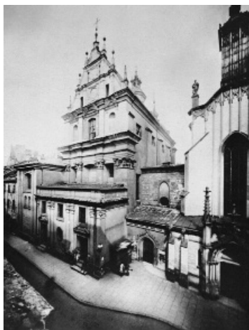
Il. 11. Sanktuarium Najświętszej Marii Panny Łaskawej przy ul. Świętojańskiej w Warszawie przed zniszczeniem podczas powstania warszawskiego. Zbiory Archiwum PWM, Warszawa
