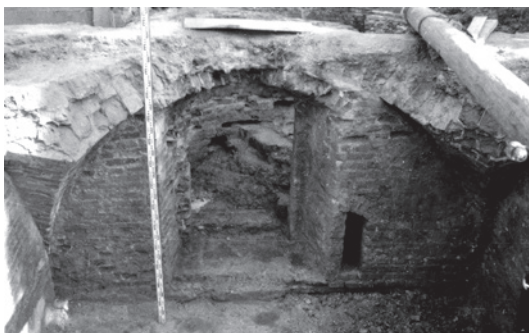
Fot. 1-2. Piwnice klasztoru bernardynów
