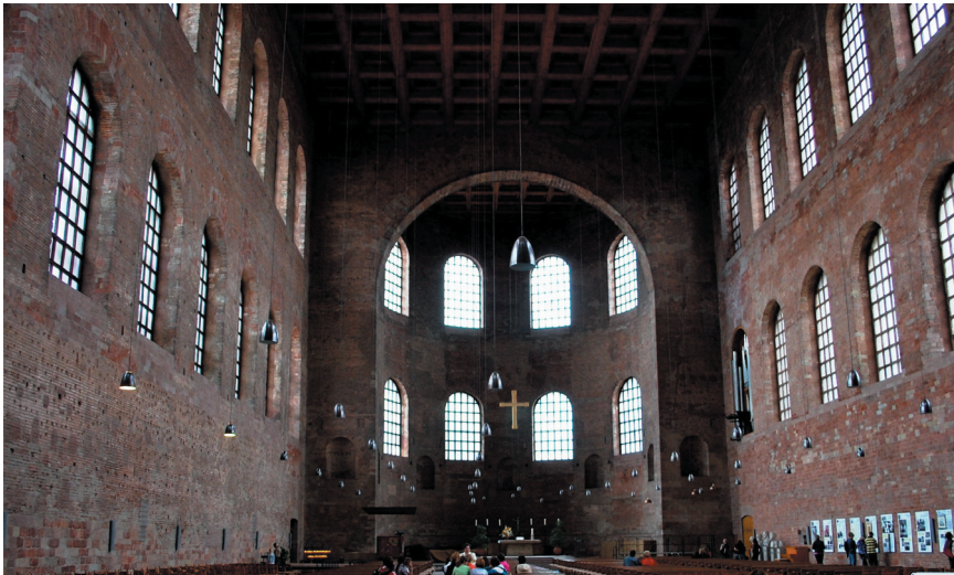
Il. 7. Trewir, Aula Palatina, ok. 310, stan obecny (widok wnętrza) (fot. Z. Kalinowski).
