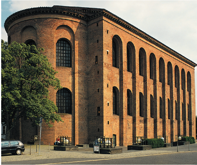
Il. 6. Trewir, Aula Palatina, ok. 310, stan obecny (widok z zewnątrz) (fot. Z. Kalinowski).
